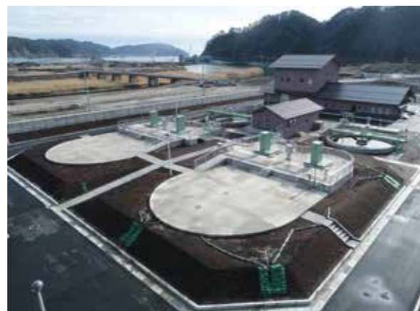
水処理設備(下水処理場水処理設備)
