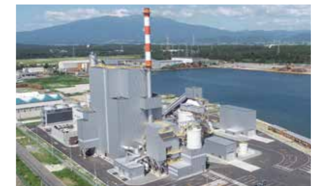
バイオマス発電プラント(サミット酒田パワー(株)納入)
