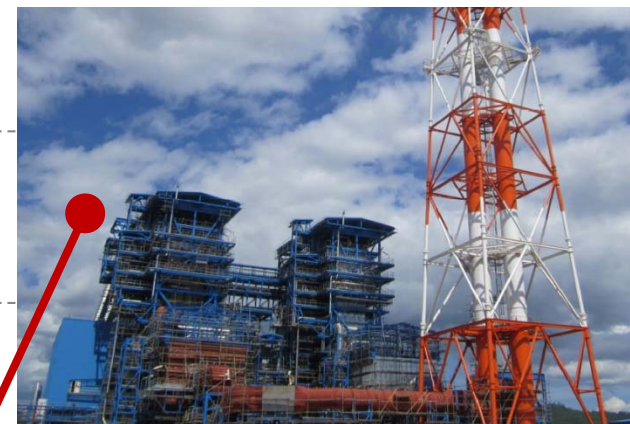
*インドネシア初号機(建設中)
