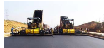
道路舗装(於:武漢)
