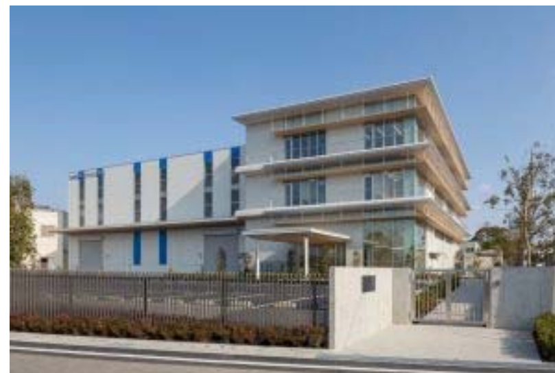
サービステクニカルセンター
