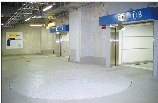
パーキングシステム事業センター
