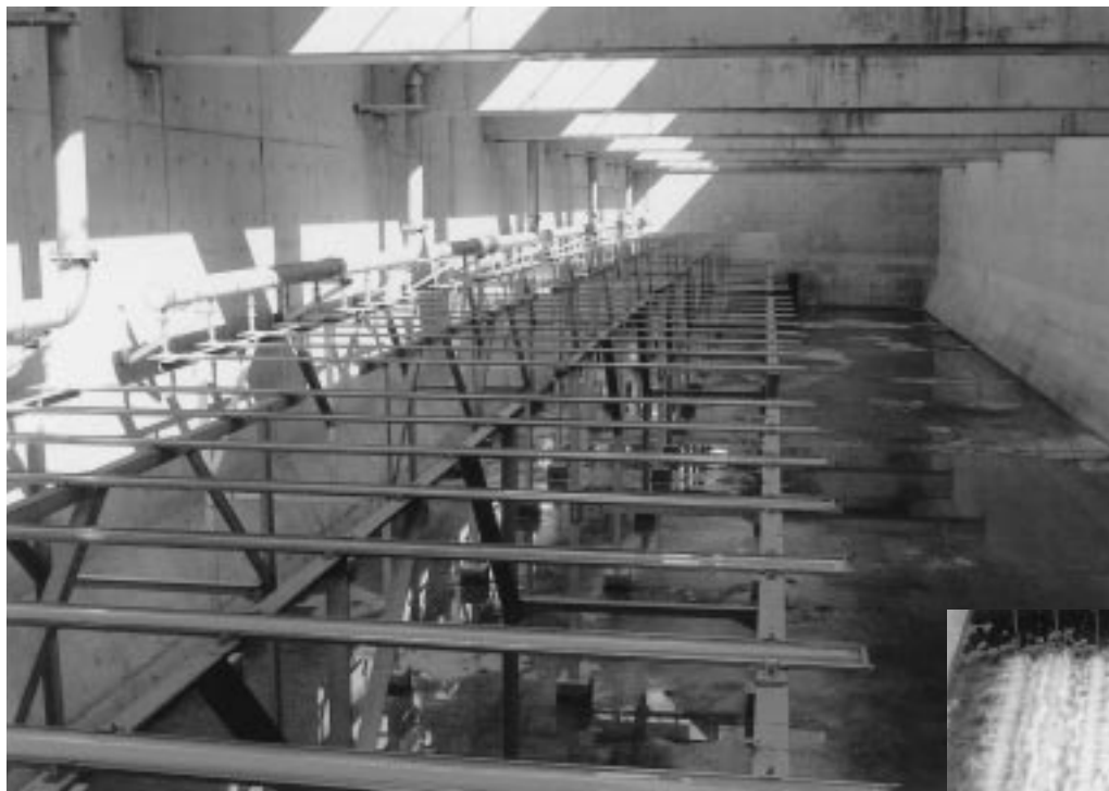
メンブレン式超微細気泡散気装置『エアレボ』 Membrane type ultra-fine bubble diffuser "AEREVO"
