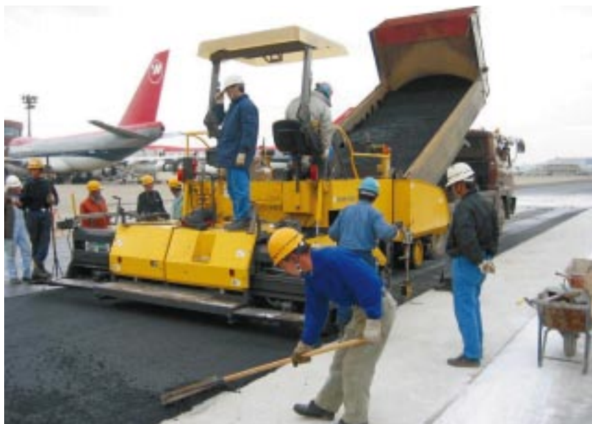
アスファルトフィニッシャ新型スクリード JP2350 New screenshot of asphaltfinisher JP2350
