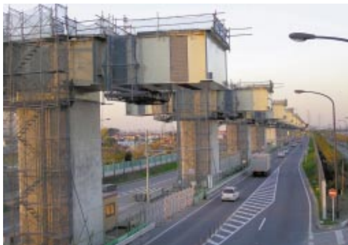
図4 栄高架橋（複合ラーメン橋） Sakae Viaduct Bridge
