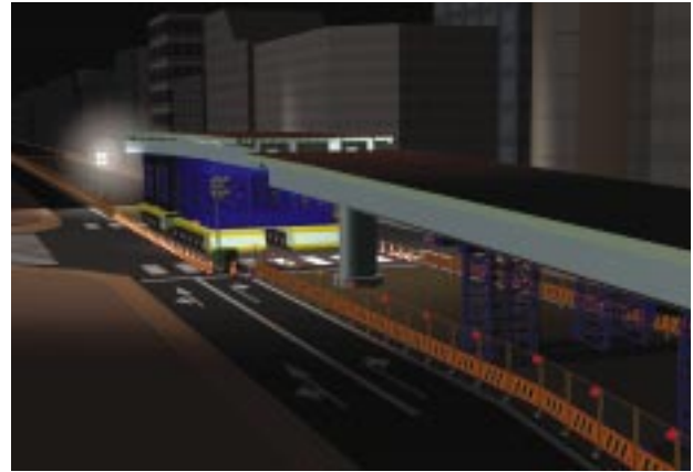
図7 中央径間架設 Erection of center span
