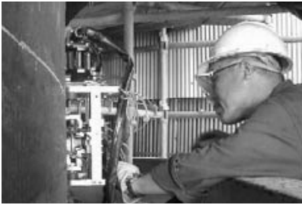
図1 コークドラムのAUT供用中検査 In-service inspection for coke drum by AUT
