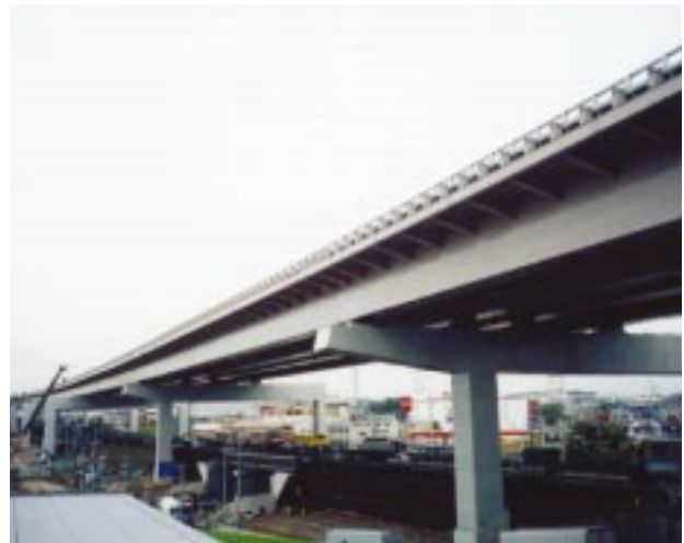
図3 有松高架橋（合理化鋼床版桁） Arimatsu Viaduct Bridge
