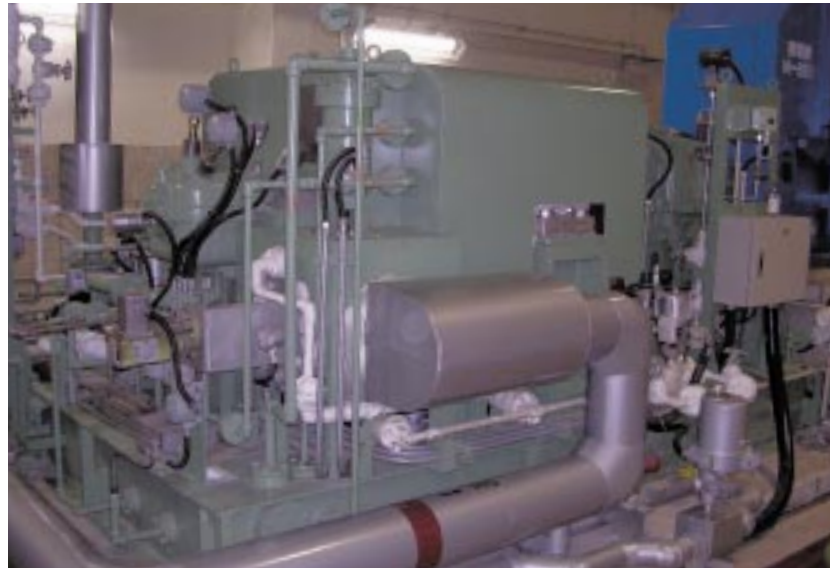
図1 NewC4蒸気タービン NewC4 steam turbine
