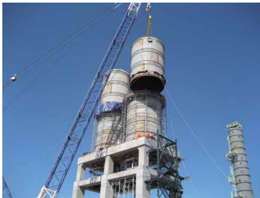
コークドラムの現地組立 Site assembly of coke drum
