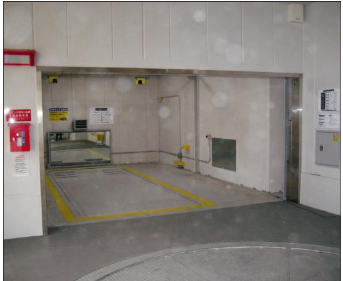
ロジスティクス&パーキングシステム事業部
