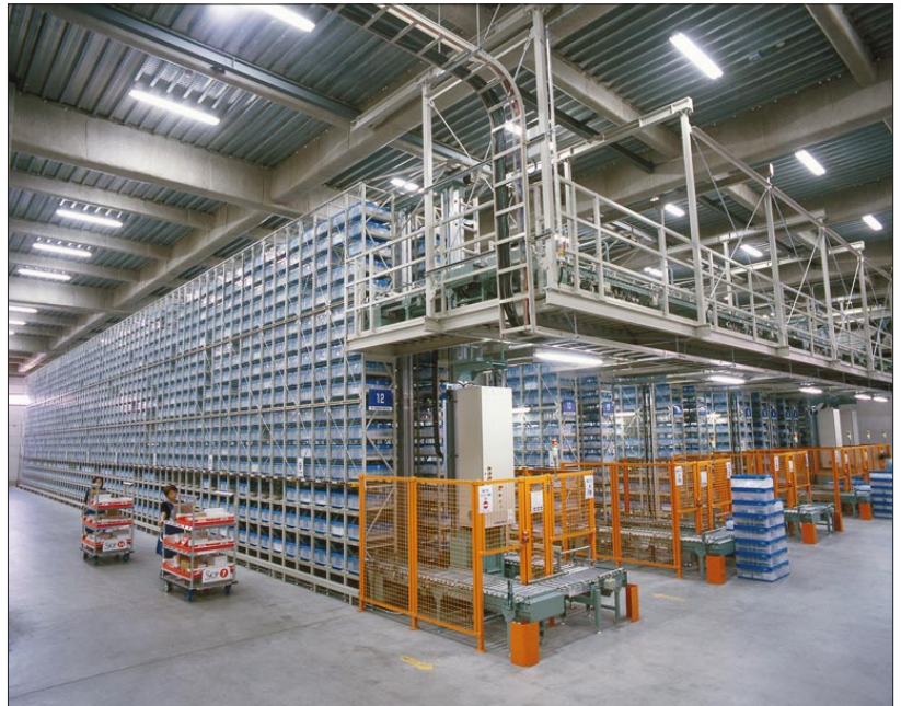
ロジスティクス&パーキングシステム事業部
