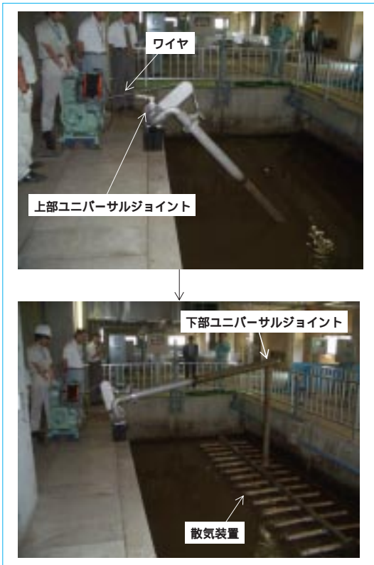
図4 散気装置吊上げシステム Diffuser-hoisting system
