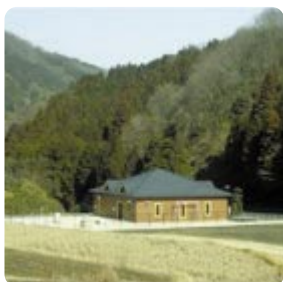
農業集落排水処理設備
