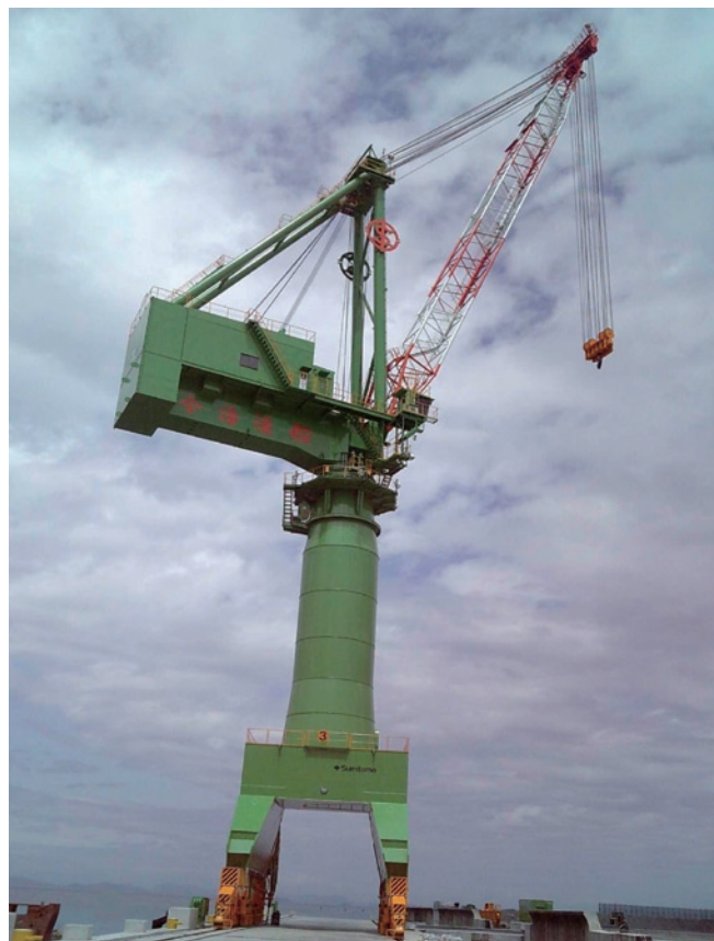
〈住友重機械エンジニアリングサービス株式会社〉
