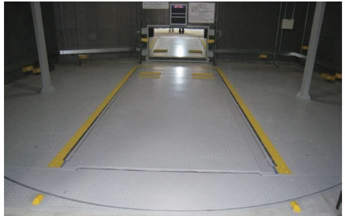
〈ロジスティクス&パーキングシステム事業部〉
