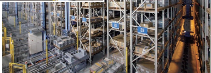
〈ロジスティクス&パーキングシステム事業部〉
