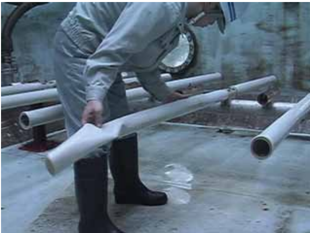
図8 メンブレンの交換方法 Replacement of membranes
