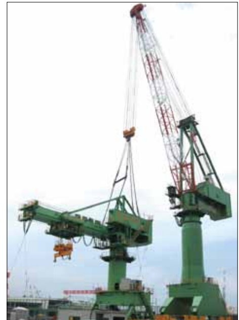
図5 ジブクレーン(JC)とつち形クレーン Rail-mounted jib crane and cantilever crane
