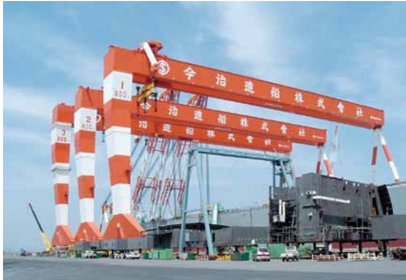
図1 ゴライアスクレーン(GC) Goliath crane
