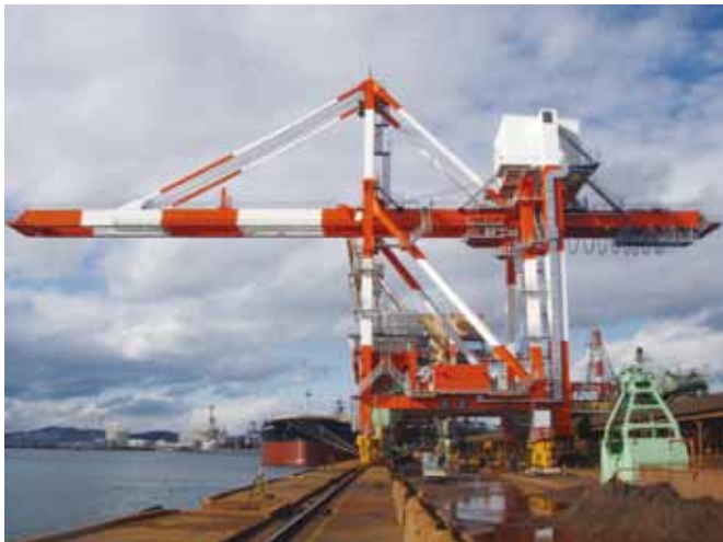
図8 橋形アンローダ Bridge type unloader
